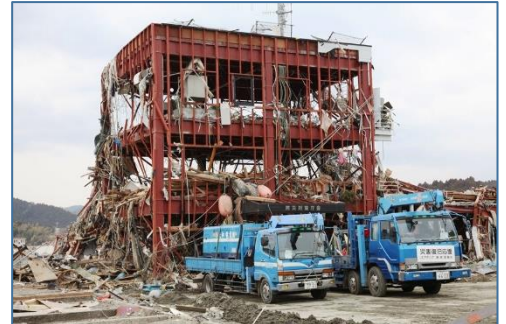
約14メートルの津波に襲われ、町職員43名の方々が犠牲となった庁舎（山村武彦氏撮影）
