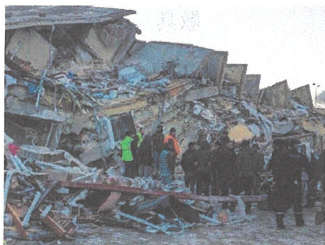
パンケーキ崩壊による被害大
