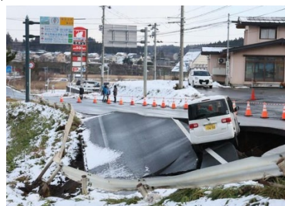
地震の影響で陥没した道路
